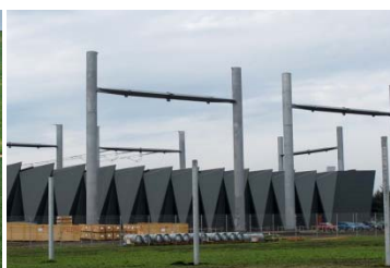
Energinet.dk er bygherre og ansvarlig for udbygningen af kabel- og transformerstationer.
