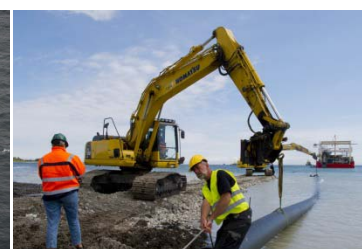
Energinet.dk er bygherre af ilandføringskablet.
